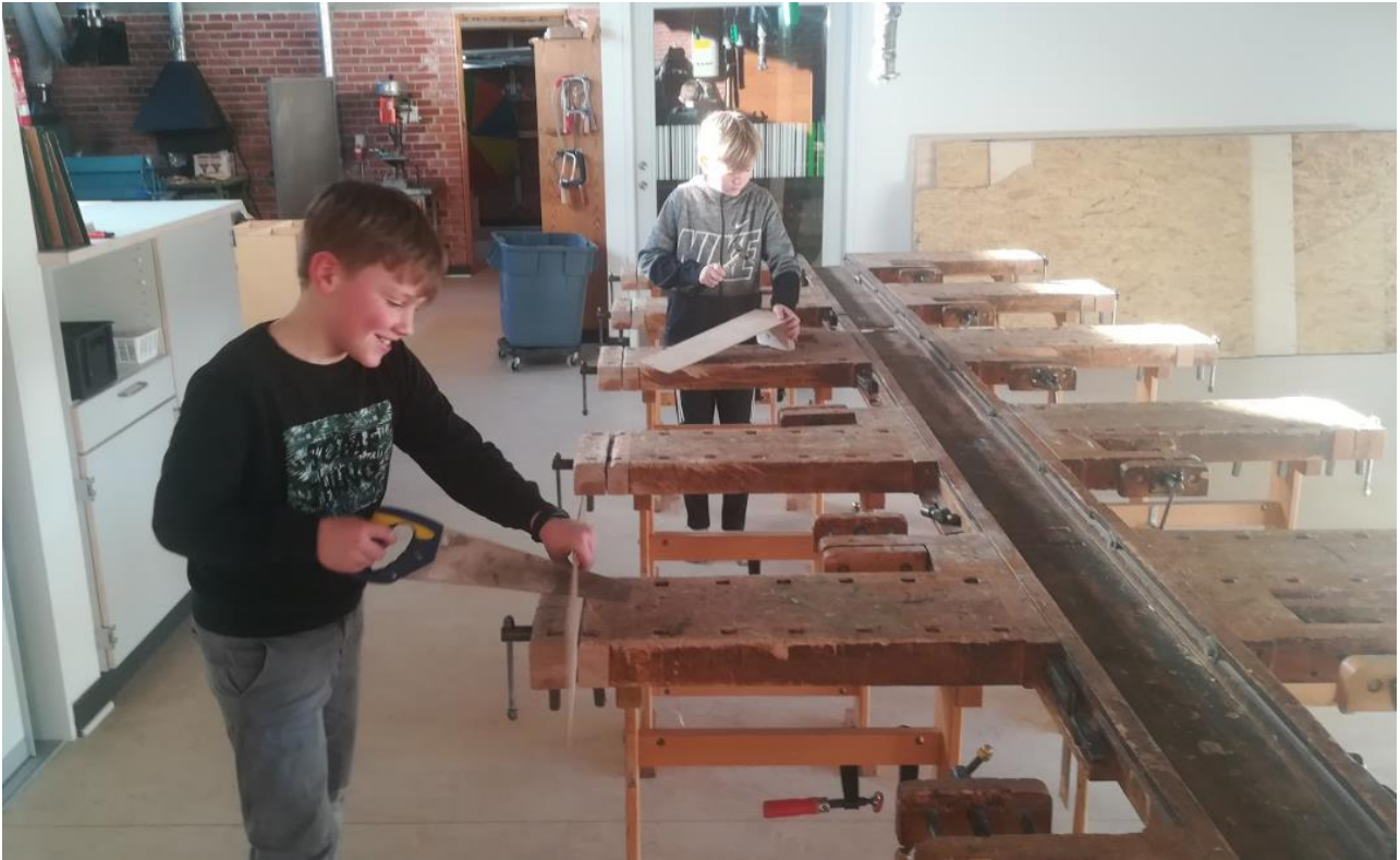
Billede 18. Drengene er i gang med at konstruere en rampe deres bil kan køre på.
